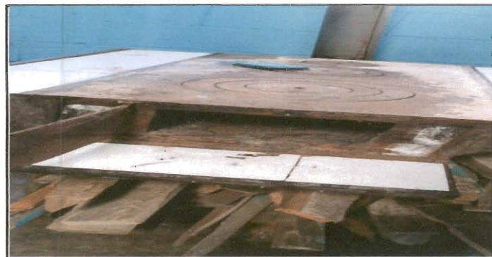
Foto 5: Las planchas de la cocina están prácticamente oxidadas
