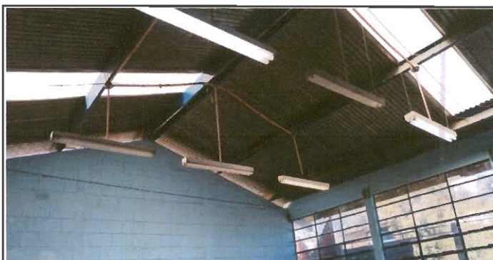
Foto 6: El alumbrado de las aulas y los corredores, son prácticamente obsoletos.
